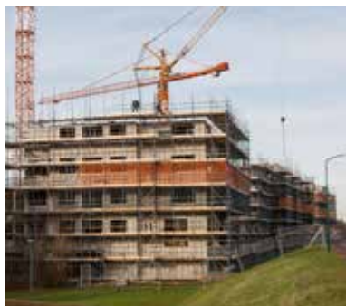
Ruwbouw van de torens
